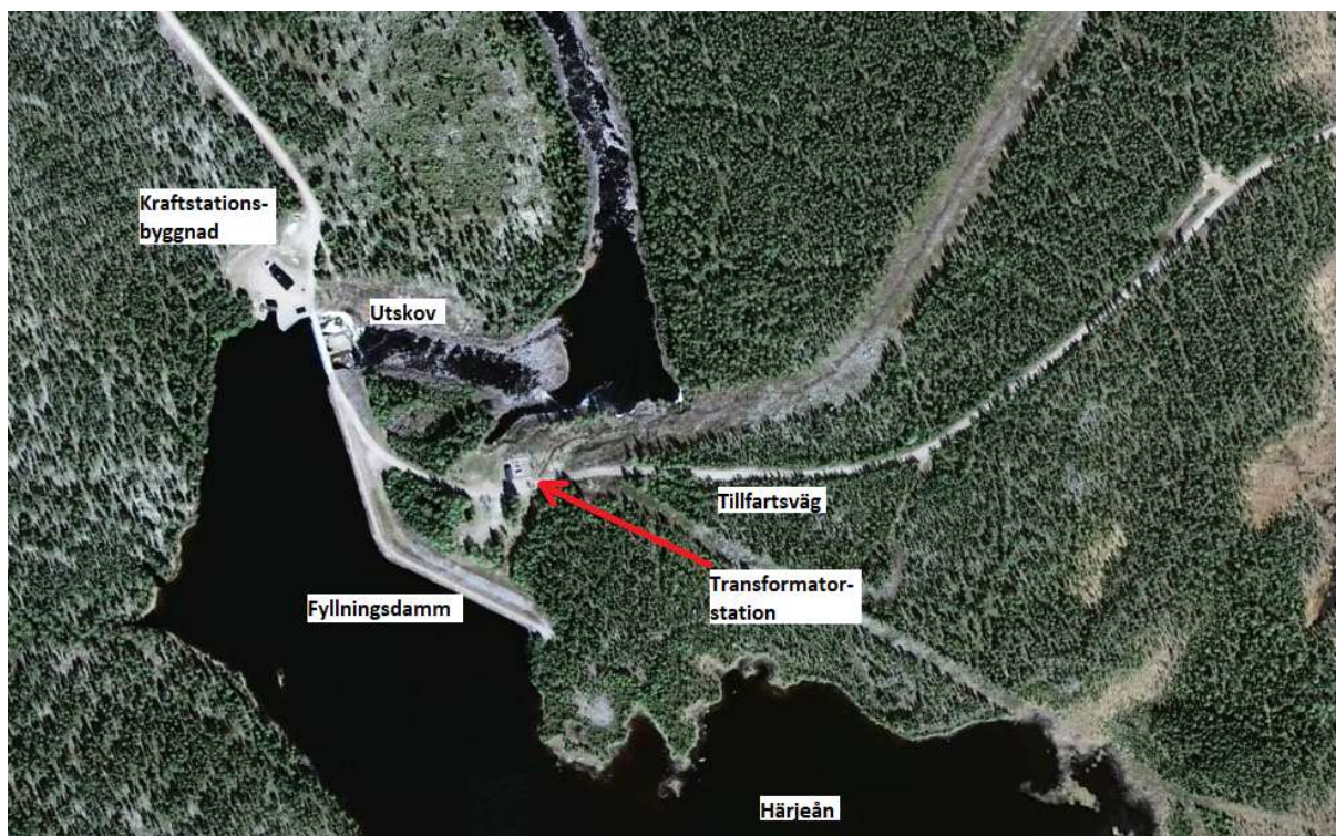
Figur 1 Flygbild över området vid vattenkraftverket i Kvarnforsen.
