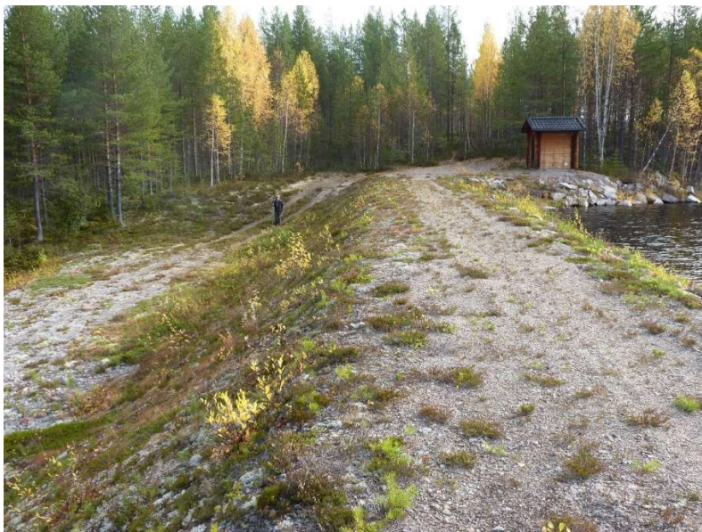
Figur 4 Inloppet placeras i fast mark uppströms fyllningsdammen, bortom pegelhuset och dras sedan genom skogsområdet överst i bild. Delsträcka 1 och 2.
