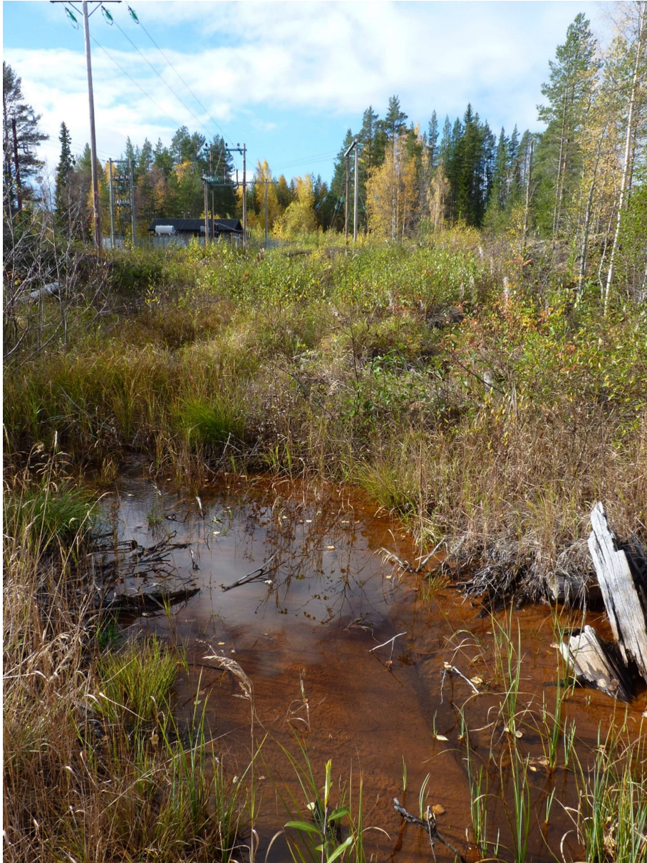
Figur 7 Dike öster om transformatorstationen, närmare mynningen, som nyttjas för att anlägga omlöpet.
