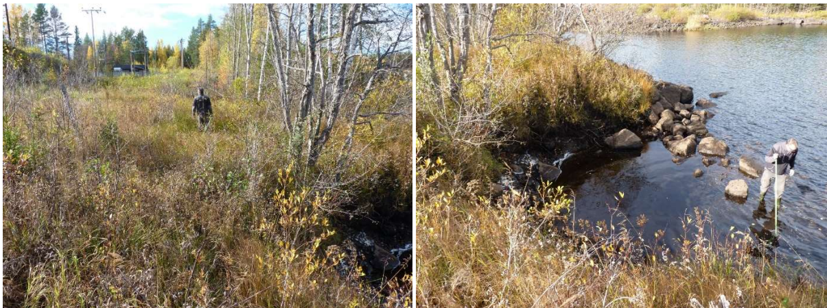
Figur 8 Omlöpets mynningsområde i selet nedströms regleringsdammen.
